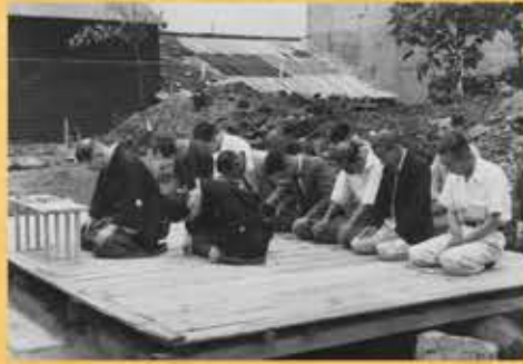
戦後、消失した能楽堂再建のための地鎮祭の光景
